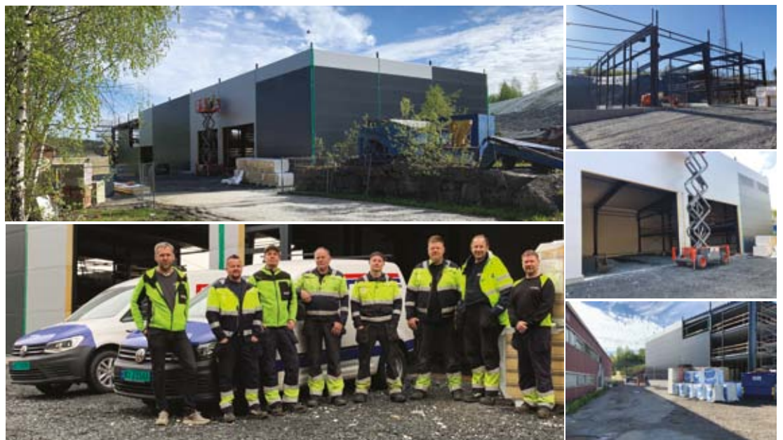
Bilder fra byggingen av de nye lokalene på Toten. Bildet nederst: Gutta fra Toten foran nybygget i Mattisrudsvingen 19.
