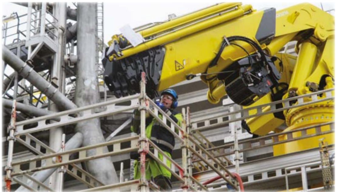
Oppstart av den nye foldekransen på Troll C plattformen.
