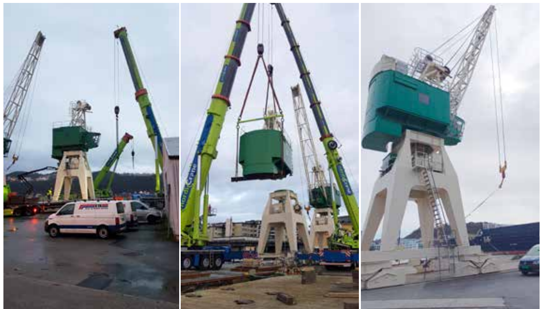
Demontering av kran i Sandnes Indre Havn.
