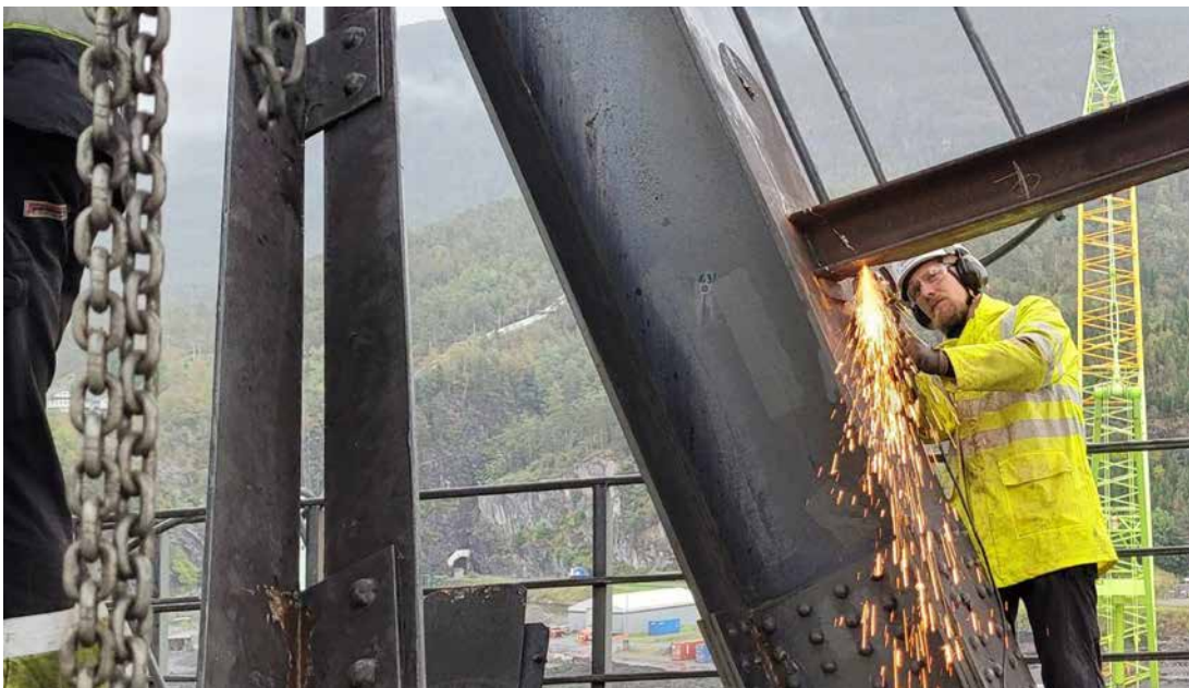
Servicetekniker Øystein H. Rusten ivrig opptatt med sveising på den store portalkranen i havneområdet hos Eramet.
