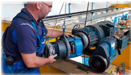
Montering av nye bremsebelegg.
