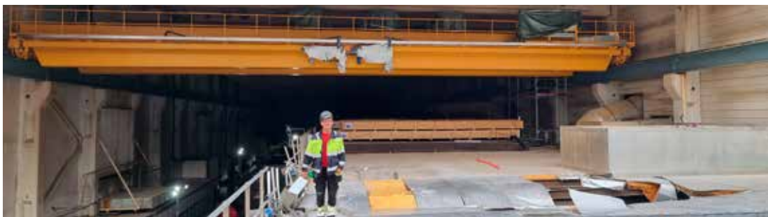
Bilde 1 ø.h.hj.: Krana på vei ut av fabrikk i Bergen. Bilde 2: Krana fraktes gjennom gatene i Halden. Bilde 3: Krana på plass i PM6 bygget hos Norske Skog Saugbrugs.
